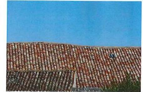
La tuile canal s'adapte au rythme de toiture
