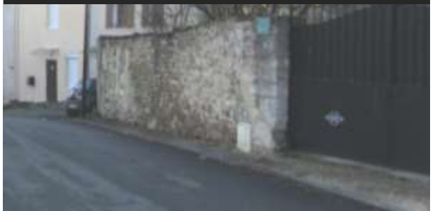
Murets (parcelle n°1033)
