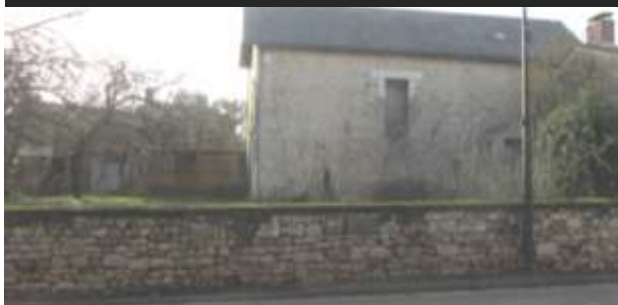
Murets (parcelle n°878,879)
