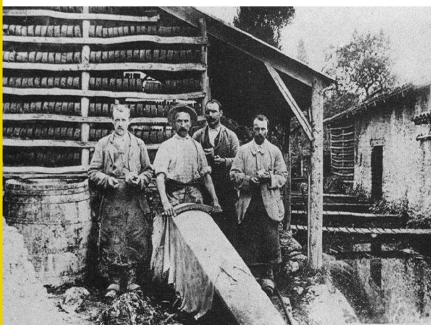
Ouvriers de la tannerie, vers 1900. À l'arrière-plan, hangars où sèchent les mottes de tan ; à droite, passerelles sur le canal d'aménée. Carte postale. Collection particulière.
