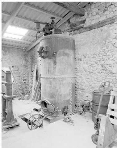
Chaudière en tôle rivetée.
