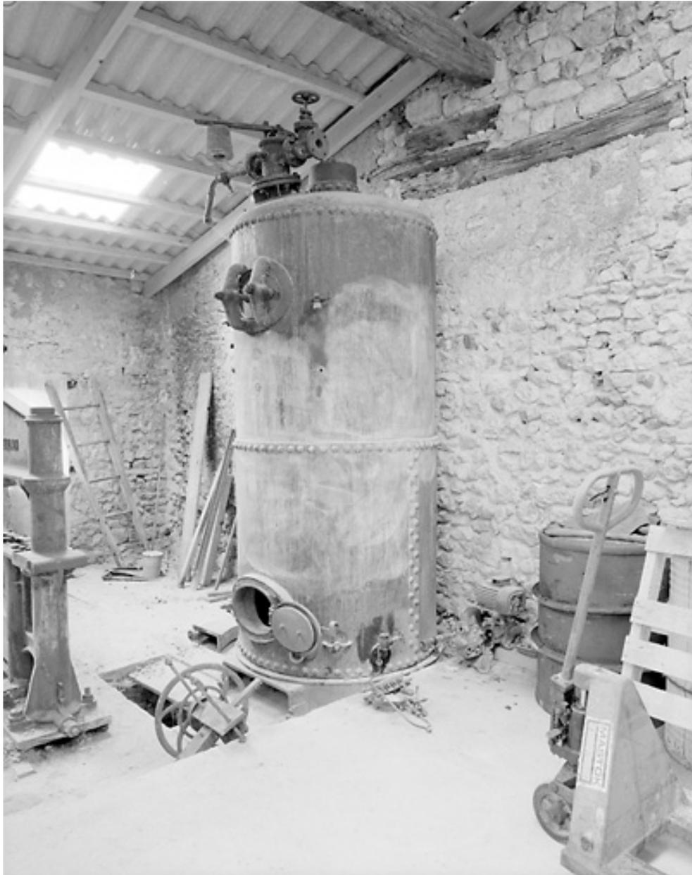
Chaudière en tôle rivetée.
