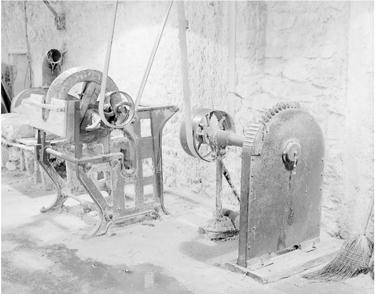
Intérieur, détail d'une doleuse et de la meule de finition.
